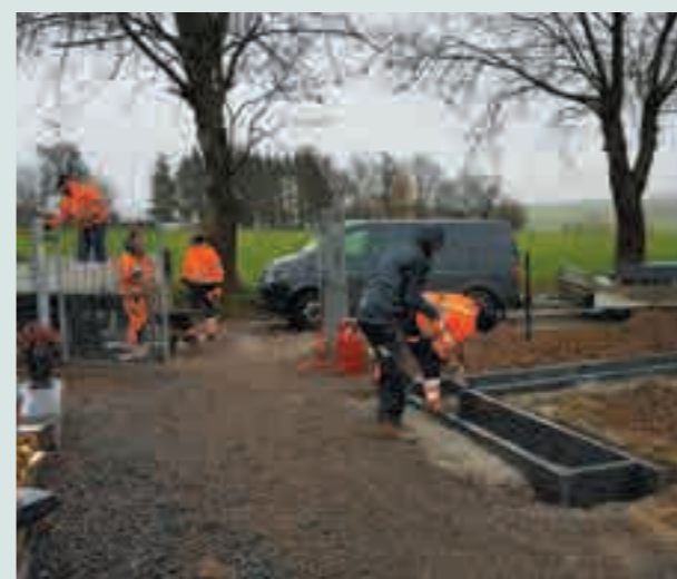
Création d'une parcelle des étoiles à Scry par le service travaux
