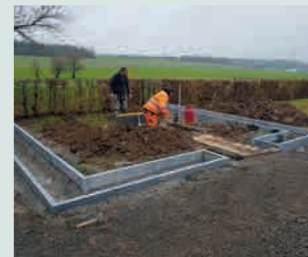
Création d'une parcelle des étoiles à Scry par le service travaux
