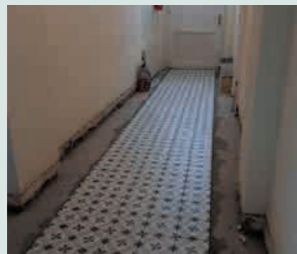
Nouveau revêtement de sol pour l'entrée du service urbanisme
